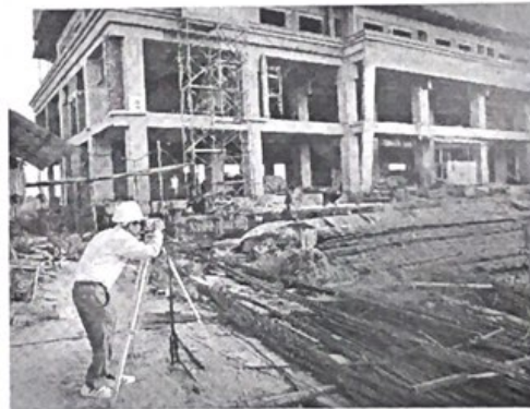
Quan trắc lún, chuyển vị công trình
