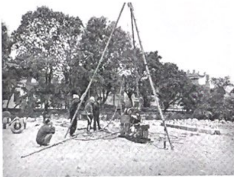
Khảo sát địa chất công trình
